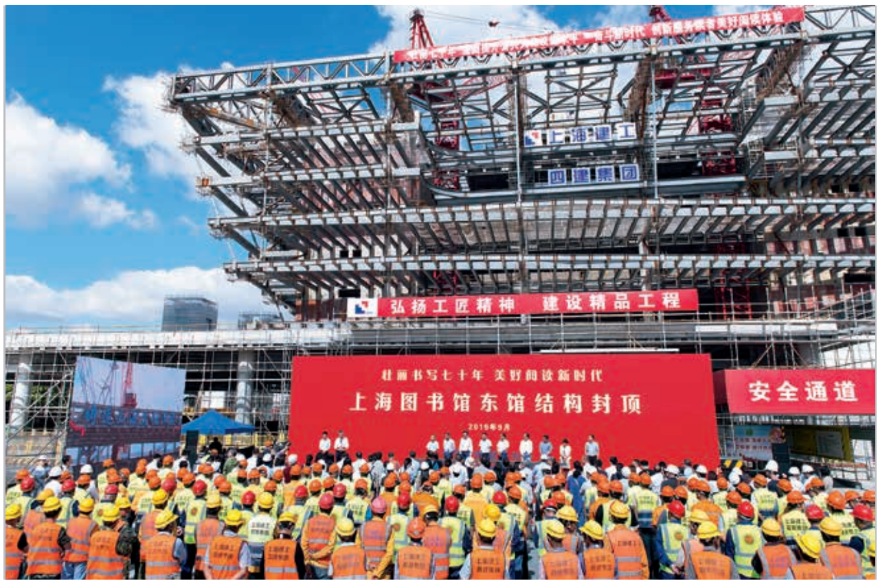
上海图书馆东馆结构封顶现场
