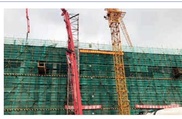
航头保存本书库建设项目结构封顶
