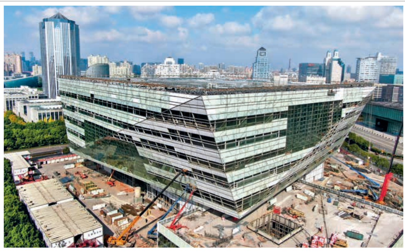
上海图书馆东馆工地现场
